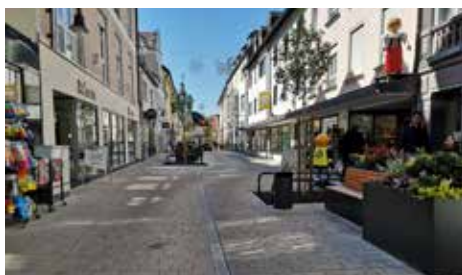
Abb. 62: Beispiel Oberflächengestaltung (Stadt Neuburg an der Donau)
