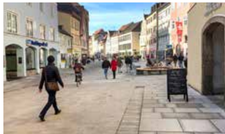
Abb. 64: Beispiel höhengleicher Ausbau und Oberflächengestaltung (Stadt Freising)
