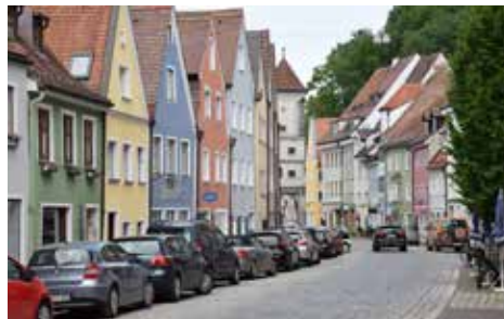
Abb. 29: Gebäude Hinterer Anger
