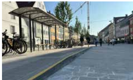
Abb. 57: Beispiel Bushaltestelle Hochbord (Stadt Freising)
